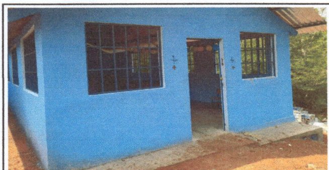
Foto 5: Se reparó la puerta y ventanas de la escuela que permiten la entrada de luz natural, hacen que las aulas se sientan más abiertas y ofrecen vistas al exterior
