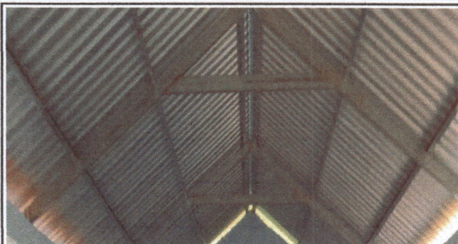
Foto 1: Se instaló la estructura del techo así se evitará las goteras dentro del aula.
